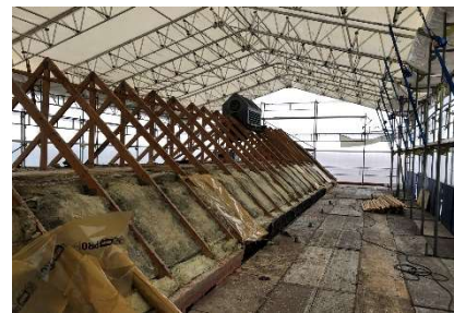
Totaloverdækning ved tag- arbejde
